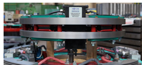
Instalare pe rotorul excitatoarei, transmitere wireless a formelor de undă ale tensiunii și curentului de excitație la hidrogenatoare
