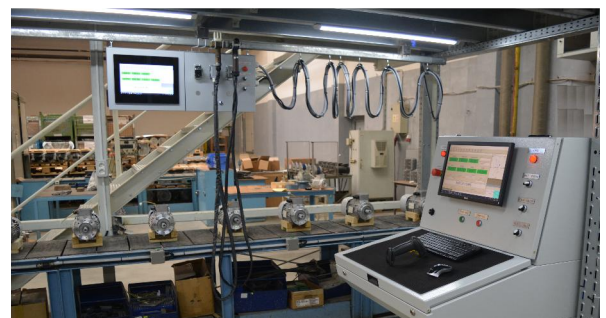
Instalare pe linia de testare, echipare cu modul de operare mobil
